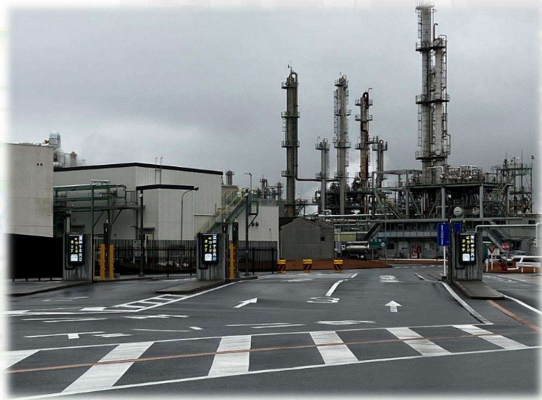
工場搬入口にて活用された事例
